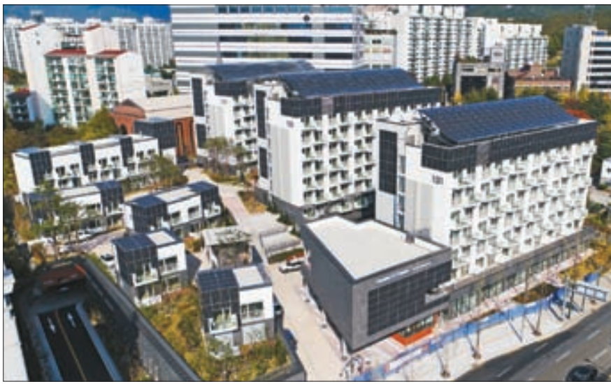
1 서울 노원구 하계동에 위치한 노원 이지하우스 전경. 아파트 3개 동을 포함, 단독주택과 연립주택 등으로 구성된 이 단지에는 121세대가 실제 거주하고 있다. 2017년 준공된 이지하우스는 국내 제로에너지 건축분야에서 이정표 역할을 했다. 2 경기 고양시 덕양구 향동지구에 위치한 에너지엑스 DY빌딩 전경. 상업용 건물로는 처음으로 제로에너지 건축물 1등급을 받은 건물로, 에너지 자립률이 121%에 이른다.
