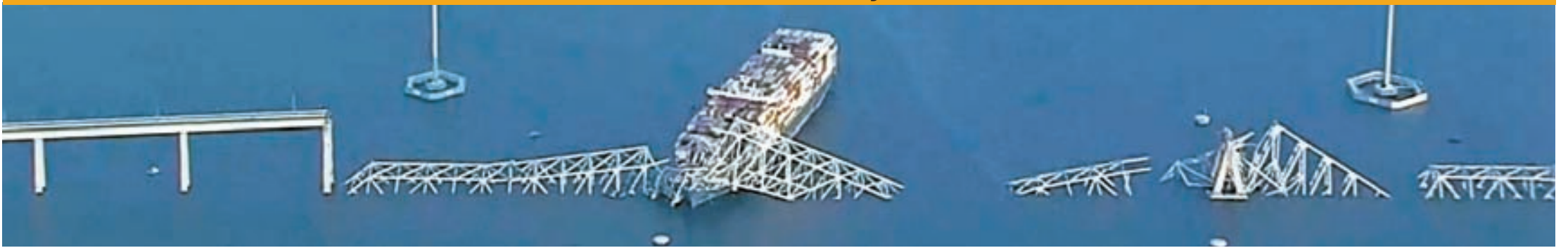
26일 싱가포르 선적 컨테이너선의 충돌로 붕괴된 메릴랜드주 볼티모어 항만의 '키 브리지'. 사고로 다리를 달리던 차량들이 물속에 추락하며, 물속에 빠진 실종자들을 수색하기 위한 작업이 계속되고 있다. [AP=연합뉴스]
