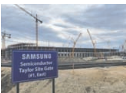
삼성전자의 텍사스주 테일러 공장 건설 현장
