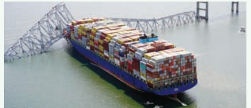
지난달 27일 메릴랜드주 볼티모어항 입구의 프랜시스 스콧 키 브리지를 무너트린 대형 화물선 ‘달리’가 다리 구조물에 걸려 있는 모습. [뉴시스]
