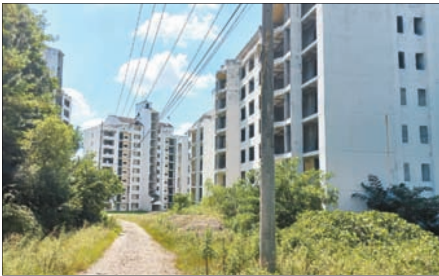
경기 용인시 처인구에 위치한 한 아파트 단지. 2000년 공사를 시작했지만 시행사 부도로 중단되면서 20년 넘게 빈 채로 방치돼 있다. [사진 용인시]
