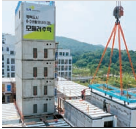
LH가 세종시 산울동 일원에 짓는 공공임대주택은 모듈러 공법이 적용된다. 트레일러에 실린 모듈러 주택(공장에서 제작된 집)을 600톤 크레인으로 들어올려 쌓아 올리는 방식이다.
