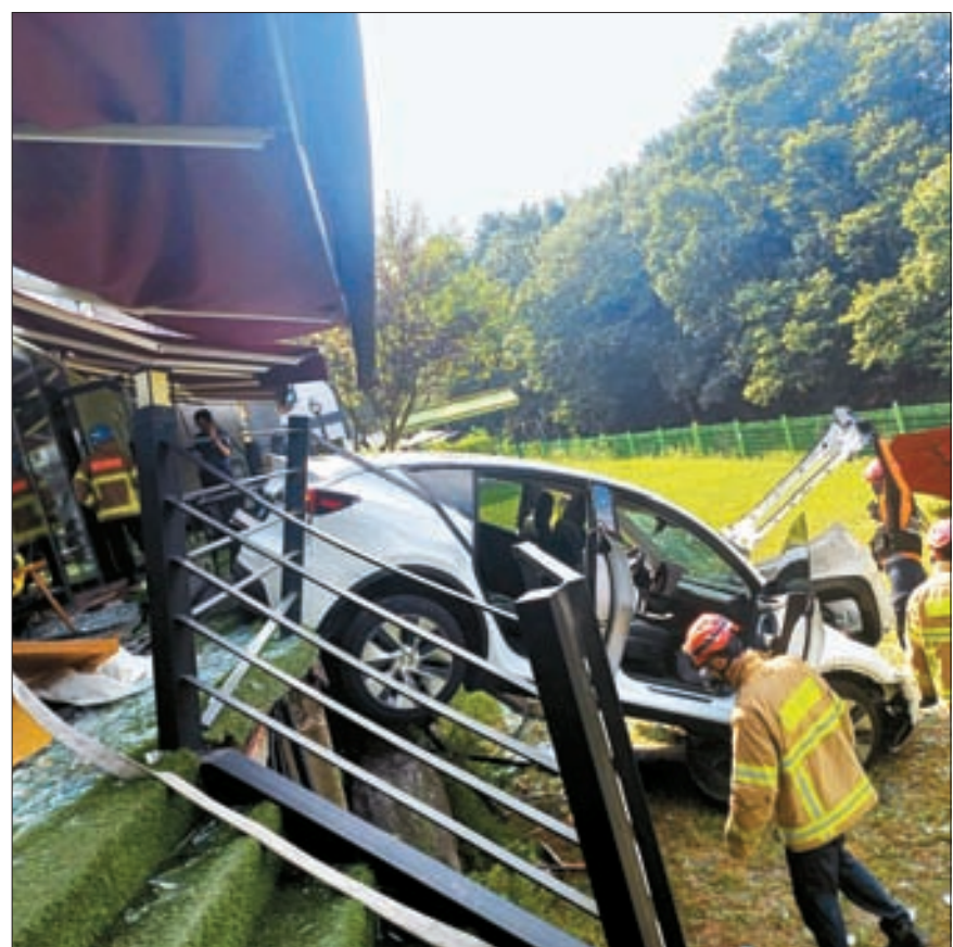
용인 카페에 전기차 돌진, 11명 부상 14일 경기도 용인시 고기동의 한 카페 건물로 60대 여성이 몰던 전기차가 돌진하는 사고가 발생했다. 이 사고로 3명이 중상, 8명이 경상을 입어 병원으로 이송됐다. 구조대원들이 건물을 통과해 멈춘 차량을 살펴보고 있다. [사진 경기도소방재난본부]
