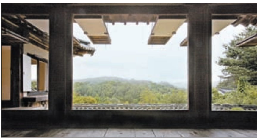
경북 안동 군자마을 후조당의 들어열개문을 열어 들춰내 걸어둔 풍경. 조선 임진왜란 전에 지어진 고택으로 1974년 안동댐이 생기면서 수몰 위기에 처한 것을 현재 위치로 옮겨왔다. [사진 이동춘]
