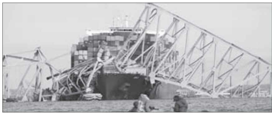
프랜시스 스콧 키 브리지와 충돌한 컨테이너 선박 위로 교량 상부 철골 구조물이 떨어져 있다. [로이터]
