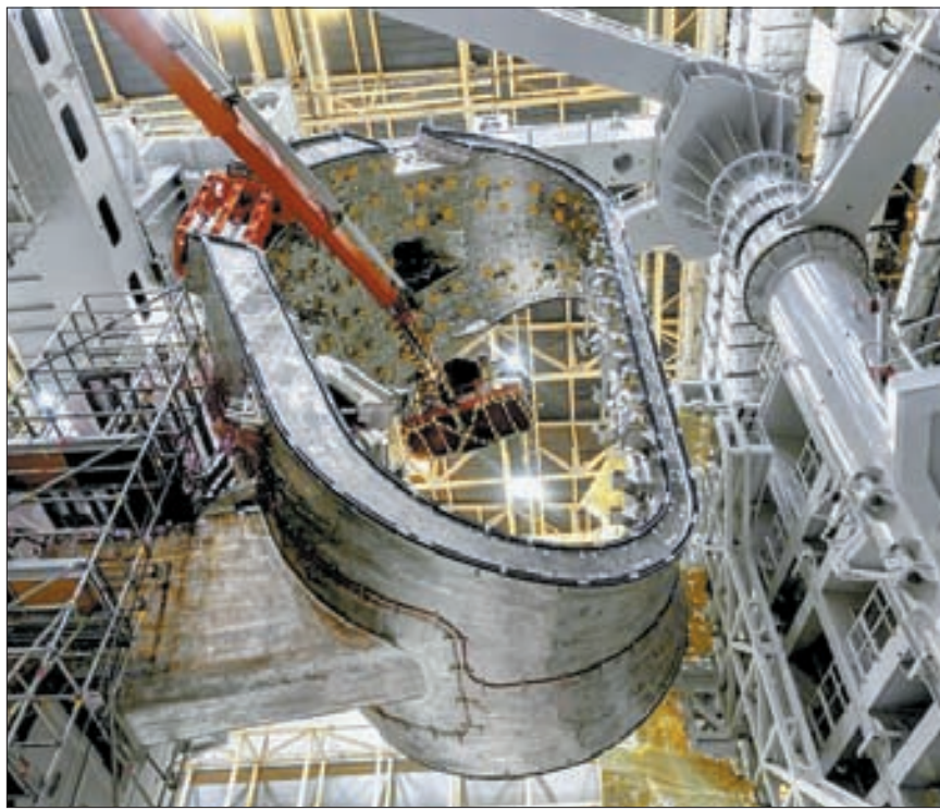
지난달 15일 프랑스 남부 카다라쉬의 국제핵융합실험로(ITER) 건설현장에서 첫번째 진공용기 부품이 조립되고 있다. [사진 ITER]
