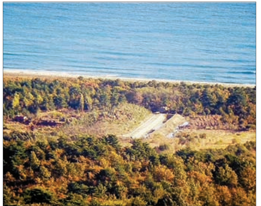
북한, 경의선-동해선에 전자 막는 휴산 북한이 남북을 연결하는 동해선을 폭파한 후 중장비를 동원해 전차를 막기 위한 대전차구와 휴산을 만든 것으로 4일 확인됐다. 사진 속 대전차구는 좌우 160m, 앞뒤 10m, 깊이 5m이며 휴산의 높이는 11m 정도다. [사진 합동참모본부]
