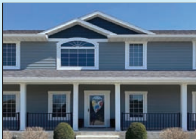
덱 / 사이딩 Deck / Siding
