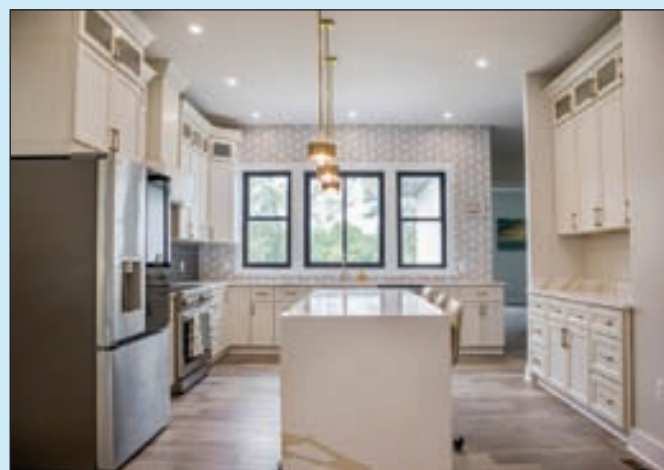
주방 리모델링 Cabinet, Sink, Faucets
