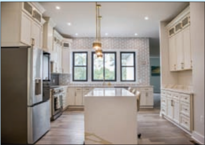
주방 리모델링 Cabinet, Sink, Faucets
