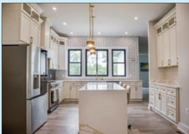
주방 리모델링 Cabinet, Sink, Faucets
