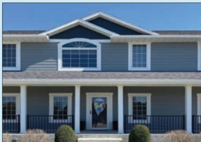
덱 / 사이딩 Deck / Siding
