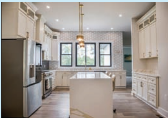
주방 리모델링 Cabinet, Sink, Faucets
