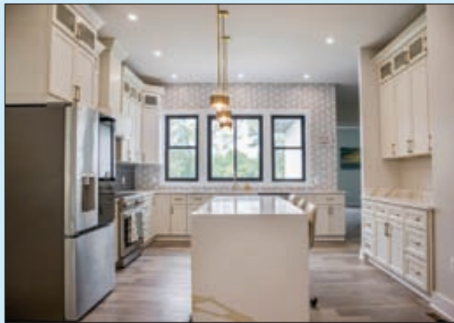
주방 리모델링 Cabinet, Sink, Faucets
