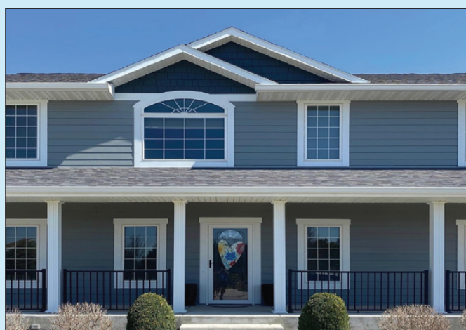
덱 / 사이딩 Deck / Siding
