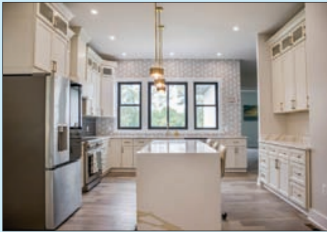
주방 리모델링 Cabinet, Sink, Faucets
