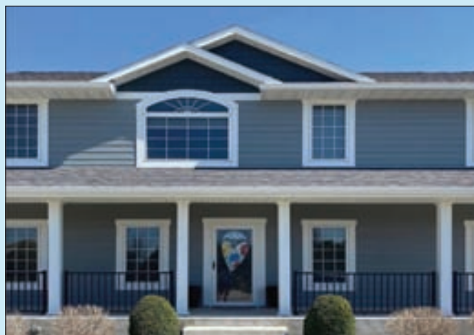
덱 / 사이딩 Deck / Siding
