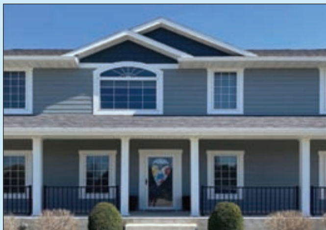
덱 / 사이딩 Deck / Siding
