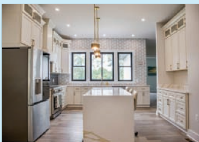
주방 리모델링 Cabinet, Sink, Faucets
