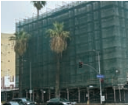
공사가 일시 중단된 신라스테이 LA 재건축 현장.
