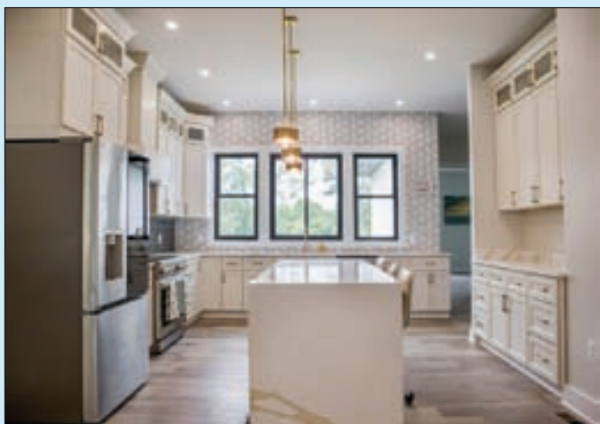
주방 리모델링 Cabinet, Sink, Faucets
