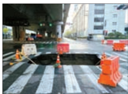
13일 부산시 사상구 도시철도 공사 현장 부근에 대형 싱크홀이 발생했다. [사진 사상구]
